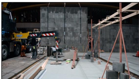
Pose sur le plancher et mise à niveau des murs sur des cales et liaisonnement au plancher au moyen de mortier sans retrait.
